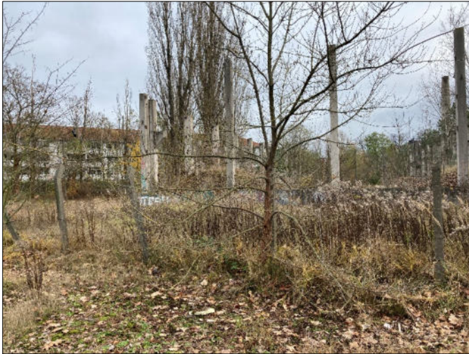
Abb.: 7 Alte Heizhausruine vor dem nunmehr abgeschlossenen Abbruch; Aufnahme Hagen Roßmann 11/2021
