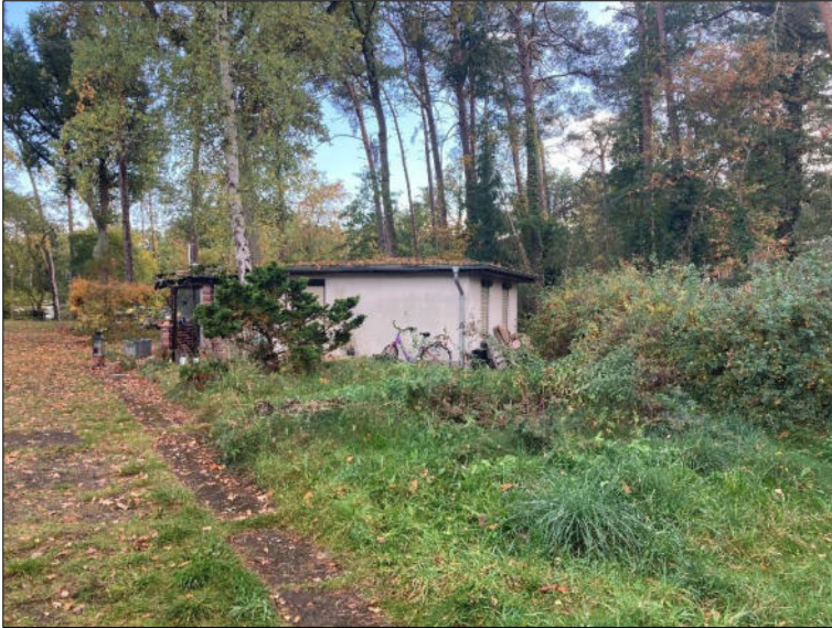
Abbildung 7: Mit Betonbefestigung überprägte Flächen und durch Ziergehölze geprägte Bereiche im Umfeld der Bebauung; Aufnahme 10/2022
