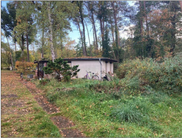
Abbildung 8: Mit Betonbefestigung überprägte Flächen und durch Ziergehölze geprägte Bereiche im Umfeld der Bebauung; Aufnahme 10/2022
