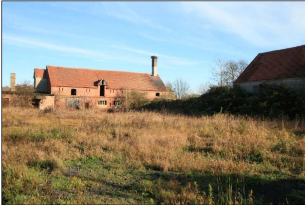
Abbildung: Das alte Hofensembel prägt die zentralen Flächen des Plangebietes.
