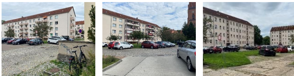
Abb. 27: Innenhofsituation (links), Blick auf einen der Parkplätze (mitte), uneinheitlicher Bodenbelag (rechts)
