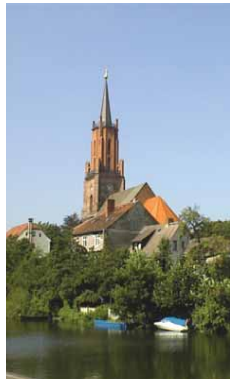
Kirche mit fertiggestelltem Turmaufbau
