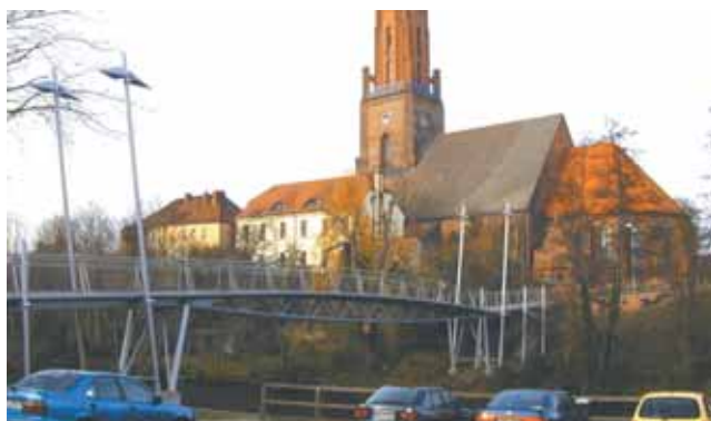
Blick auf die neue Brücke
