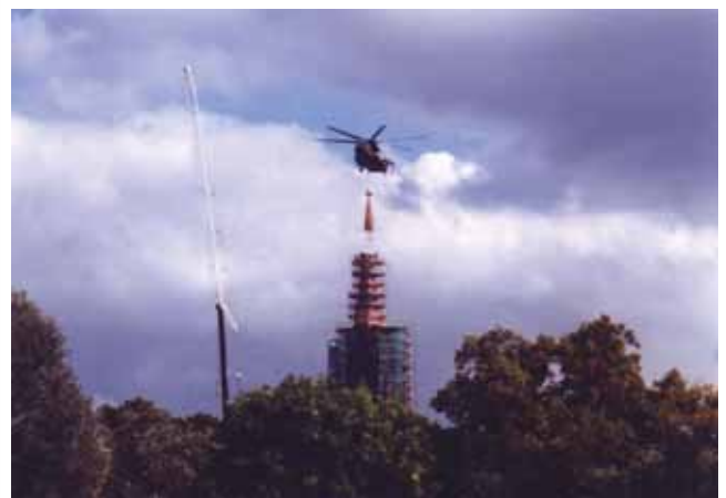
Wiederaufbau des Turmes, während der Turmbauarbeiten 2002
