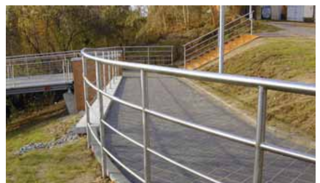
Zugangsbereich der Kirchbergbrücke am Kirchberg
