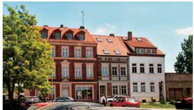
Gebäudezeile an der Jederitzer Straße nach der Sanierung
