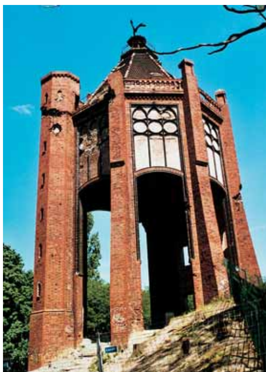
Bismarckturm vor der Sanierung (Mai 2001)
