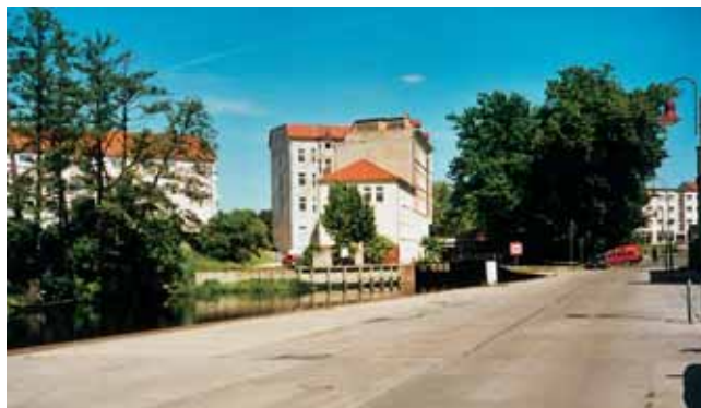
Uferbereich am Schleusenkanal als Freiflächenpotential
