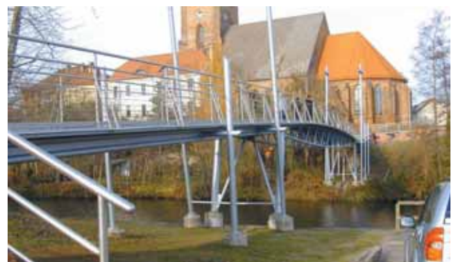
Zugangsbereich der Kirchbergbrücke am Stadthafen
