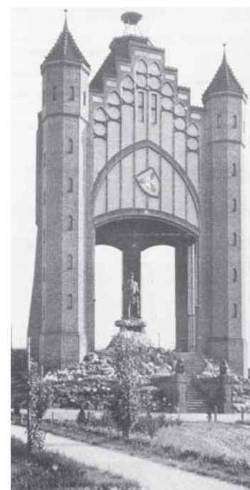
Historische Aufnahme Bismarckturm
