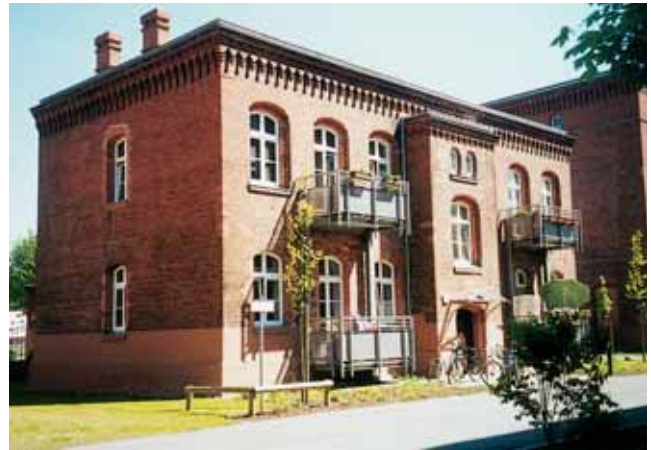
Sanieretes Wohngebäude der ehemaligen Zietenkasernen
