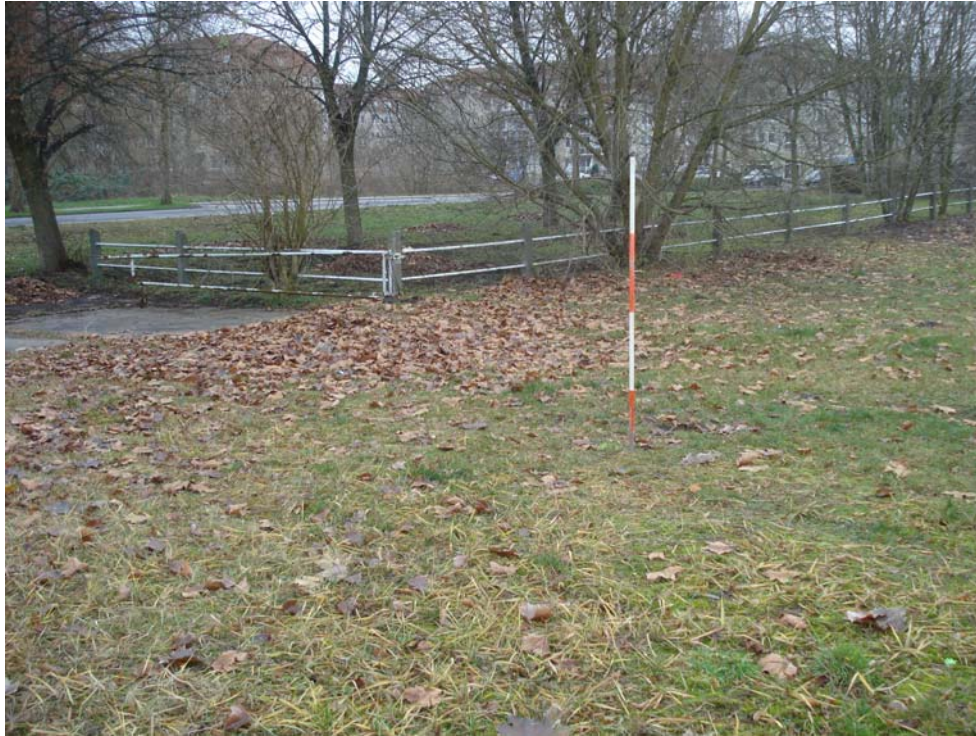
01. Ansicht Kleinrammbohrung BS 01, leichte Rammsondierung DPL 01
