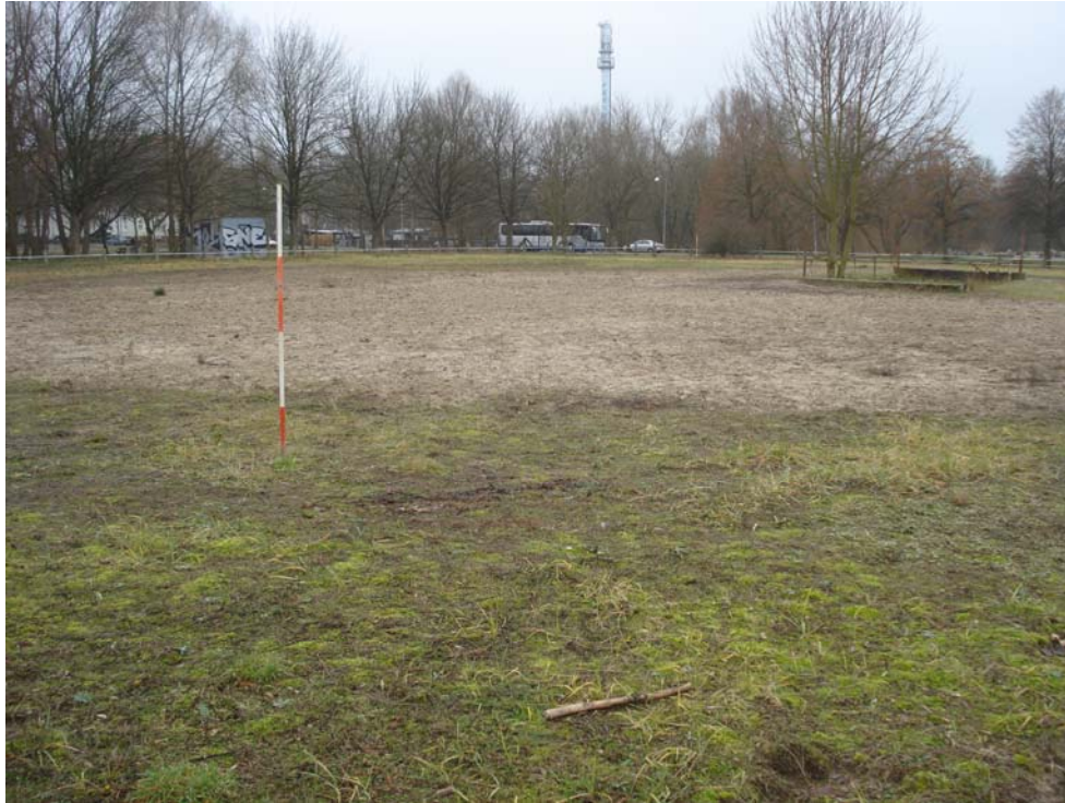
03. Ansicht Kleinrammbohrung BS 03, leichte Rammsondierung DPL 03
