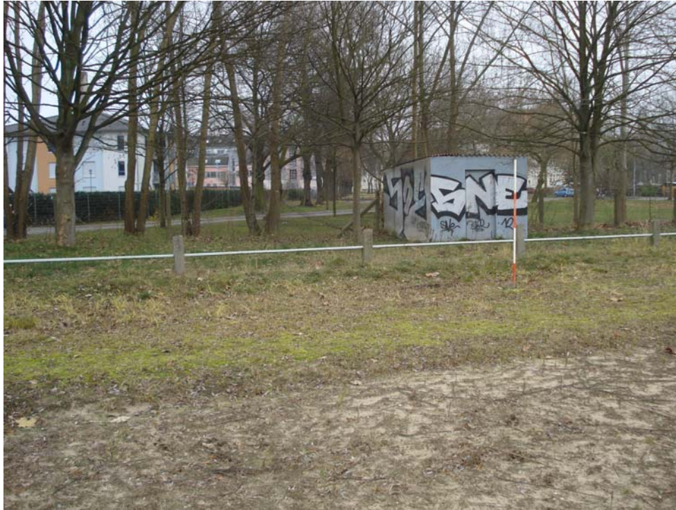
09. Ansicht Kleinrammbohrung BS 09
