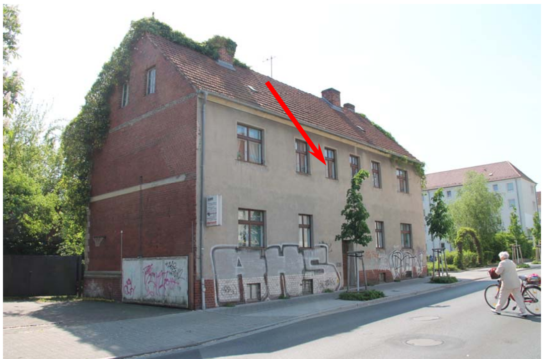
Foto 4: Blick über die Fehrbelliner Straße in Richtung Südosten auf die Westfassade des Wohngebäudes IO 3 „Fehrbelliner Straße 3“ .
