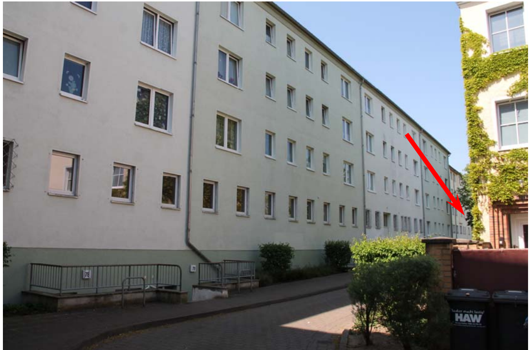
Foto 7: Blick in Richtung Westen auf die Nordfassade des Wohngebäudes IO 7 „Berliner Straße 82“.
