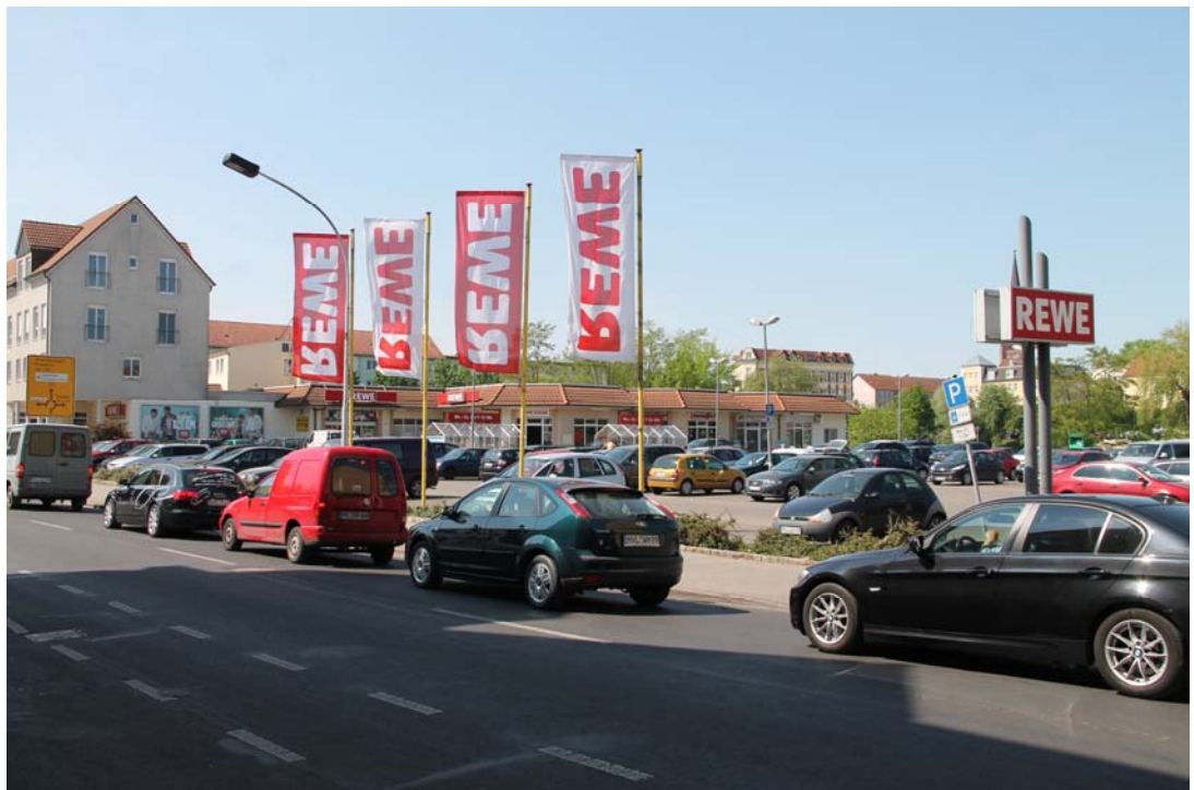
Foto 2: Blick von der Fehrbelliner Straße in Richtung Südwest über den Pkw-Parkplatz vor dem derzeitigen REWE-Markt, der an gleicher Stelle neu errichtet werden soll.
