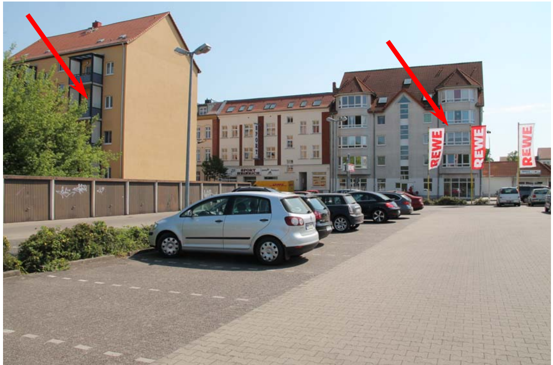
Foto 3: Blick von der NW-Ecke des B-Plan-Gebietes über den nördlichen Bereich des PKW-Parkplatzes. Der linke Pfeil zeigt die Westfassade des Wohngebäudes IO 1 „Fehrbelliner Straße 37“ und der rechte die Westfassade des Wohn- und Geschäftshauses IO 2 „Fehrbelliner Straße 4a“ .
