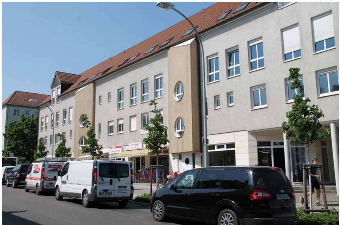
Foto 10: Blick über die Fehrbelliner Straße in Richtung Südwesten auf die kleineren Verkaufseinrichtungen im B-Plan-Gebiet. Die darüber liegenden Wohnungen ab dem 1.OG müssen als maßgebliche Immissionsorte im Zuge der zukünftigen Baugenehmigungsverfahren beachtet werden.
