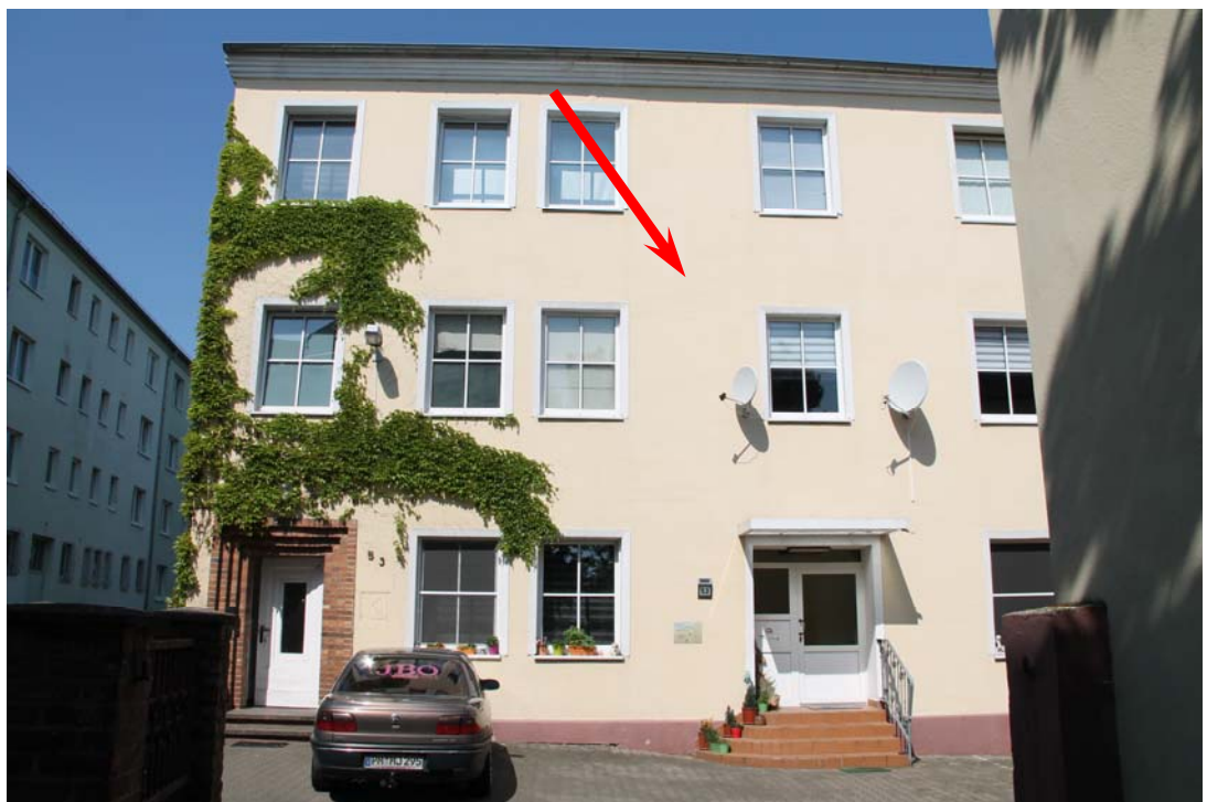
Foto 6: Blick von der Fehrbelliner Straße in Richtung Westen auf die Ostfassade des Wohngebäudes IO 6 „Fehrbelliner Straße 53“ .
