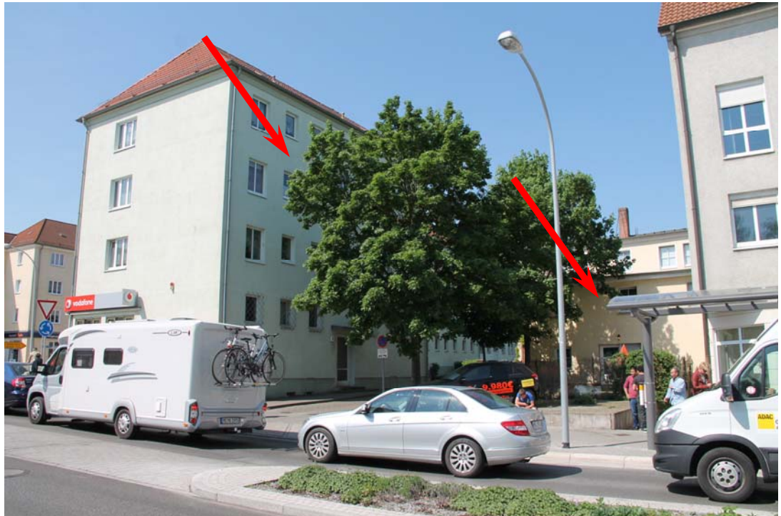
Foto 5: Blick über die Fehrbelliner Straße in Richtung Südwesten auf die Nordfassade des Wohngebäudes IO 4 „Berliner Straße 77“ (linker Pfeil) und die Ostfassade des Wohngebäudes IO 5 „Fehrbelliner Straße 52“ (rechter Pfeil).
