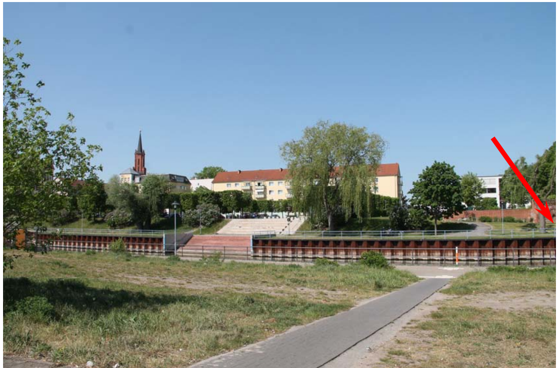
Foto 8: Blick vom westlichen Rand des Plangebietes über den Stadtkanal in Richtung Westen auf die Wohngebäude an der „Baustraße“. Der maßgebliche Immissionsort IO 8 ist die NO-Ecke des in Richtung Stadtkanal vorgelagerten geplanten Wohngebietes.
