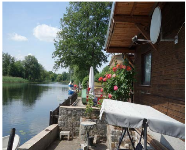
04.06.2019 / Uferverbau östl. Plangebiet
