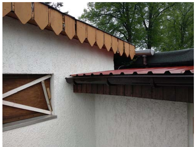
29.04.2019 / pot. Nischen + Verstecke zwischen Dachkonstruktionen
