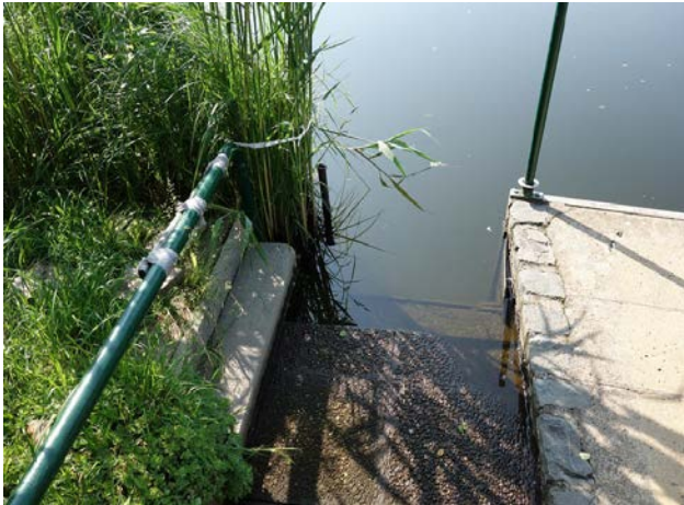
04.06.2019 / Wechsel zwischen Uferpflanzung+Verbau / Mittl.Plangebiet
