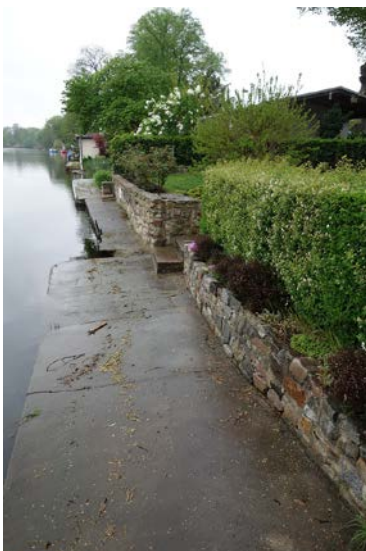
29.04.2019 / Uferverbau mit Ortbeton und Stützmauer östl. Abschnitt
