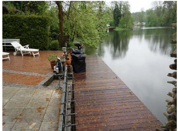
29.04.2019 / Uferverbau und Steganlage und Steganlage / Östl. Plangebiet
