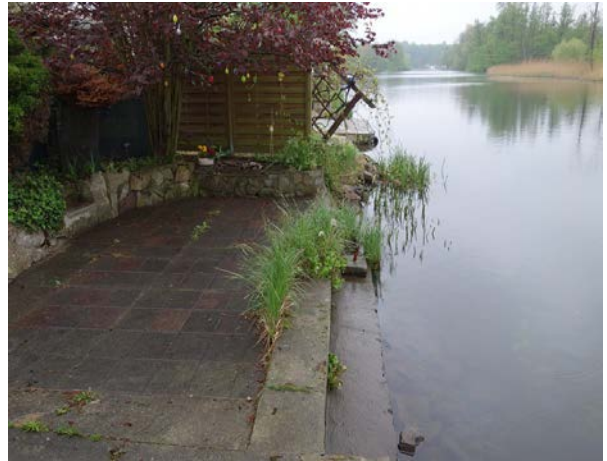
29.04.2019 / Uferverbau / Mittleres Plangebiet
