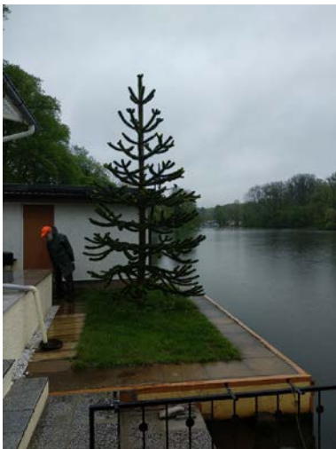
29.04.2019 / Uferverbau, mittl. Abschnitt
