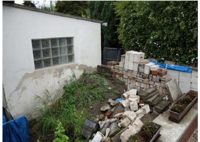
29.04.2019 / Pot. Verstecke in länger gelagerten Baumaterialien, östl. Abschnitt
