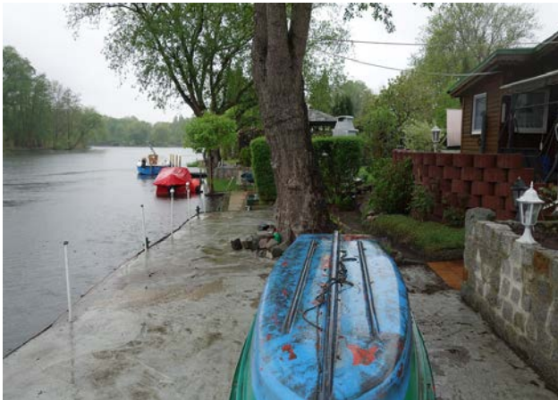
29.04.2019 / Uferverbau / Mittleres Plangebiet
