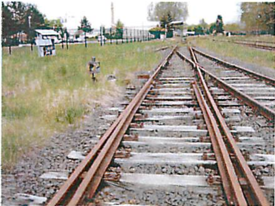
Abbildung 9: Holzschwellen im Weichenbereich
