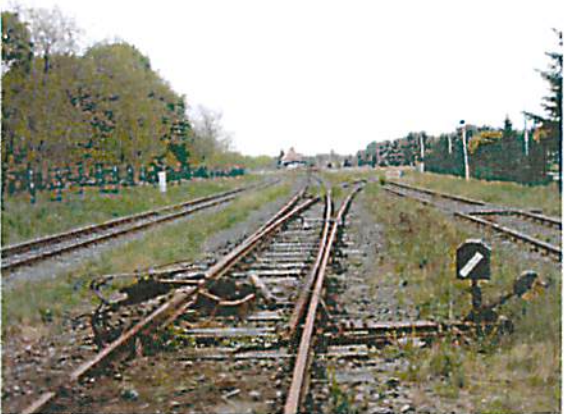
Abbildung 5: Altmetallteile techn. Anlagen
