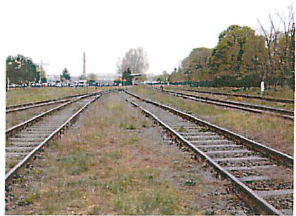
Abbildung 2: Gleisanlage südlich der Rampe
