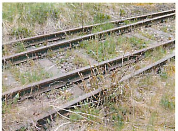
Abbildung 12: Stahlschwellen
