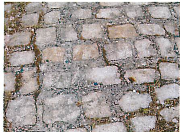
Abbildung 23: verfugtes Granitpflaster
