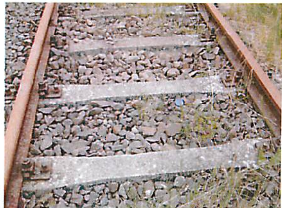
Abbildung 8: Betonschwellen neben der Rampe
