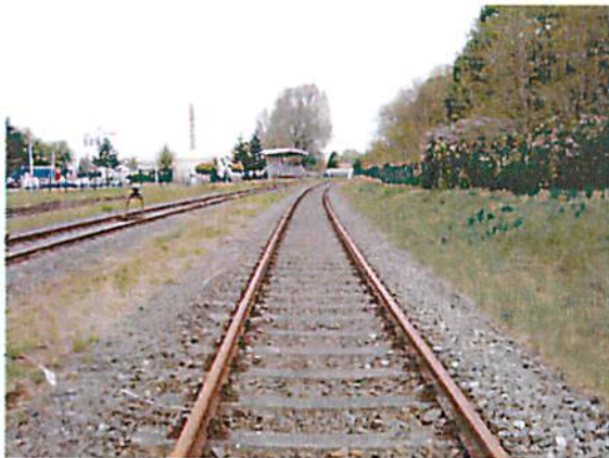
Abbildung 7: Betonschwellen durchgehendes Gleis
