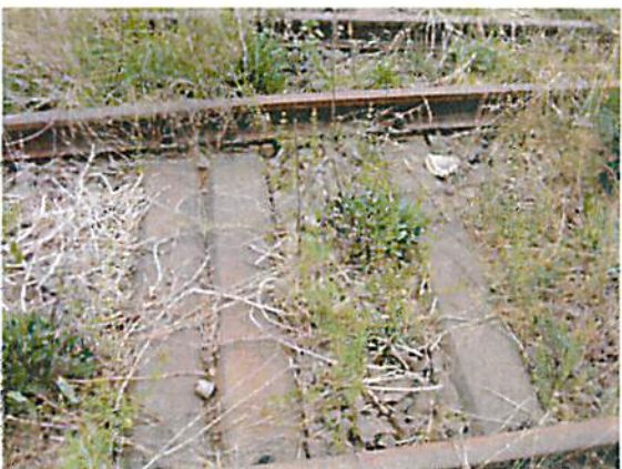
Abbildung 11: Stahlschwellen
