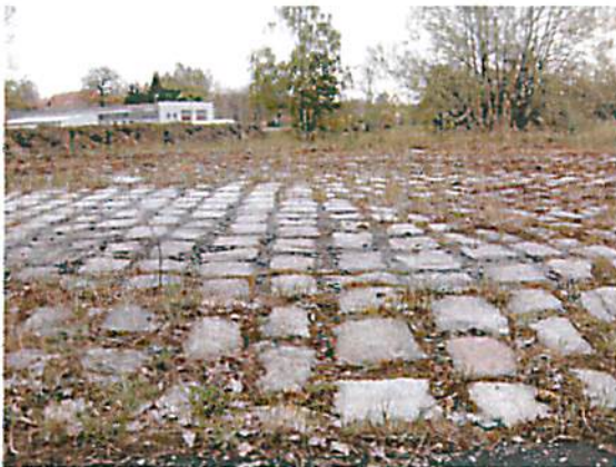
Abbildung 22: verfugtes Granitpflaster
