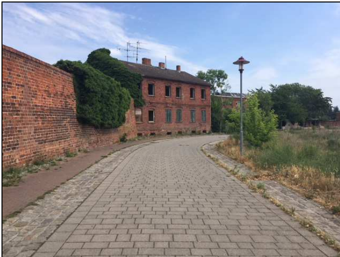
Abbildung 8: Stadtmauer im Bereich der Baderstraße; (Aufnahme 06/2018)
