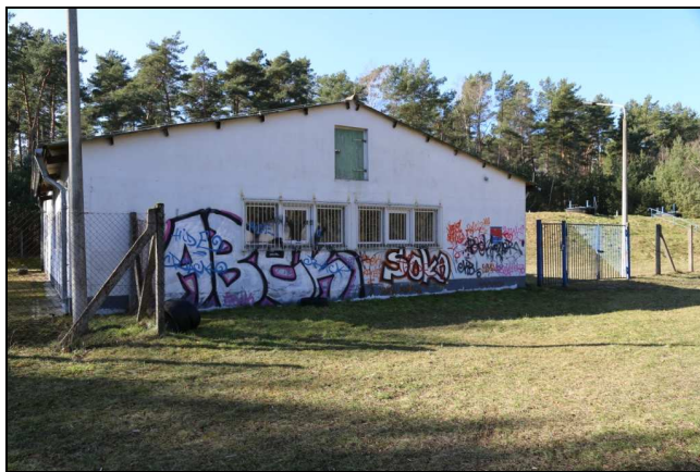
Abbildung 8: Wasserwerk in der Gemarkung Steckelsdorf; Gebäude, Flächenbefestigungen und Zäune sollen vollständig abgebrochen werden
